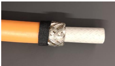
Bild 28: Schirmgeflecht umlegen und fixieren
